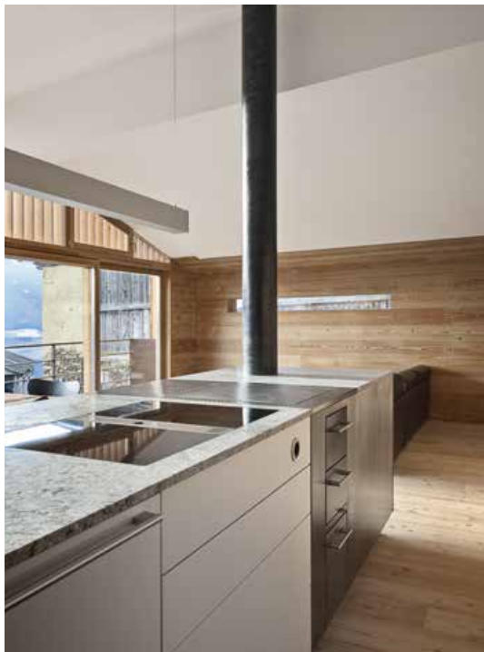
SPEZIELLER KÜCHENHERD MASSGEFERTIGT MIT SEITLICHEN RAUCHGASZÜGEN, WELCHE DIE BEHEIZUNG DER GESAMTEN WOHNZONE ERMÖGLICHEN
